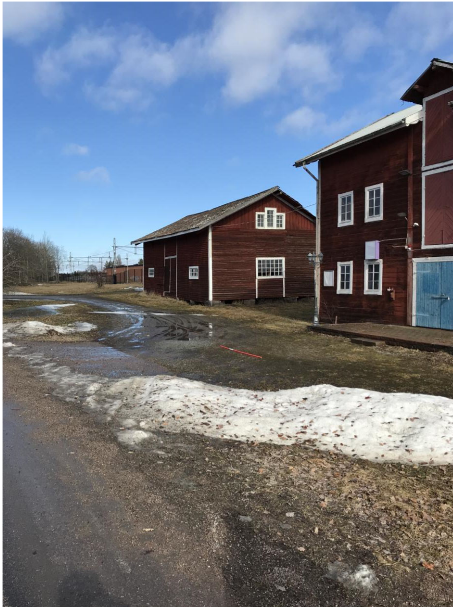
Byggnaderna söder om planområdet.
